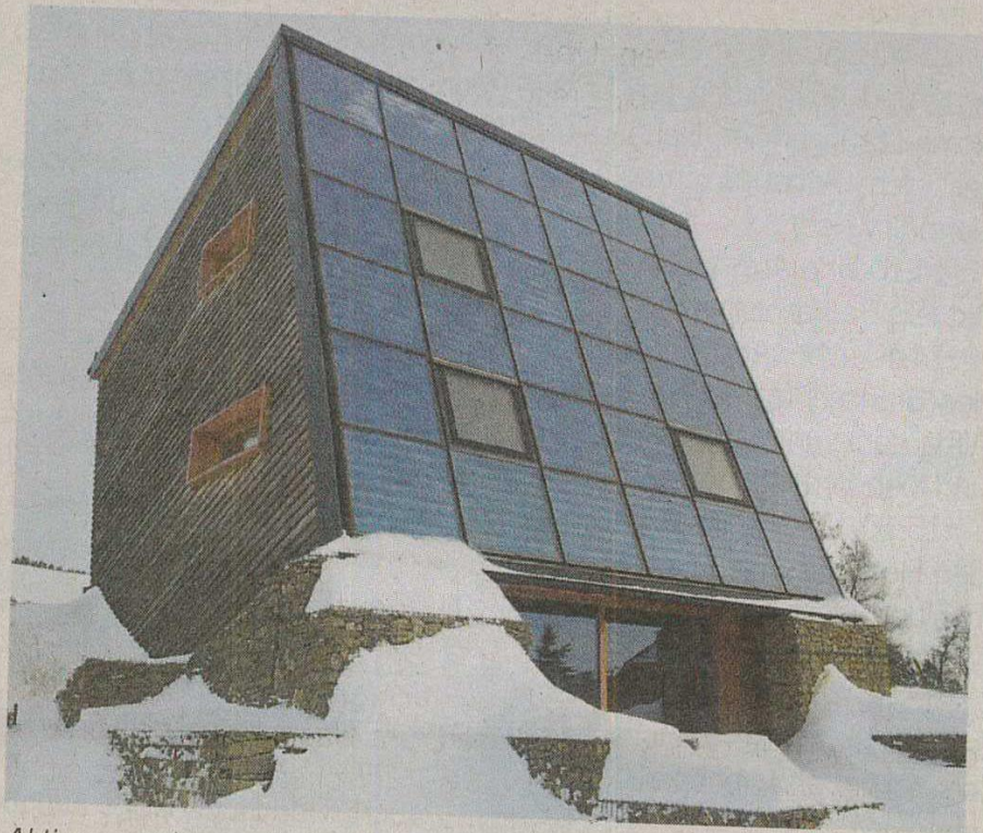
Aktivsonnenhaus ENERGETIKhaus100® cube
