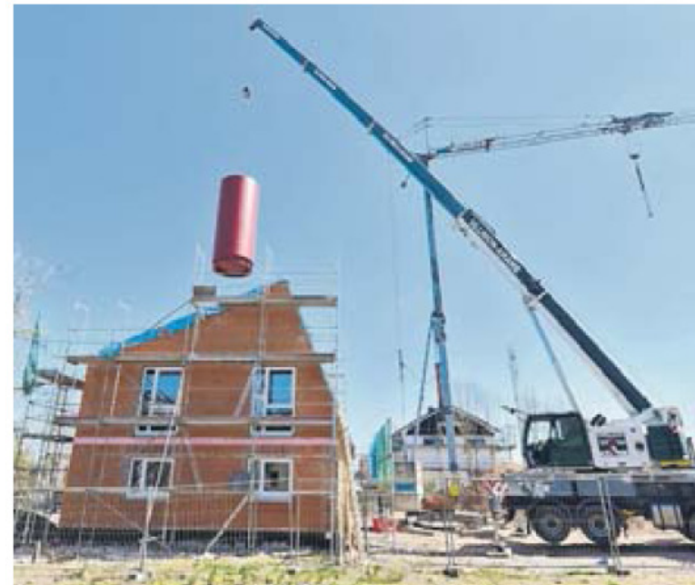
Im Solar Areal wurde der letzte Speicher gesetzt.
