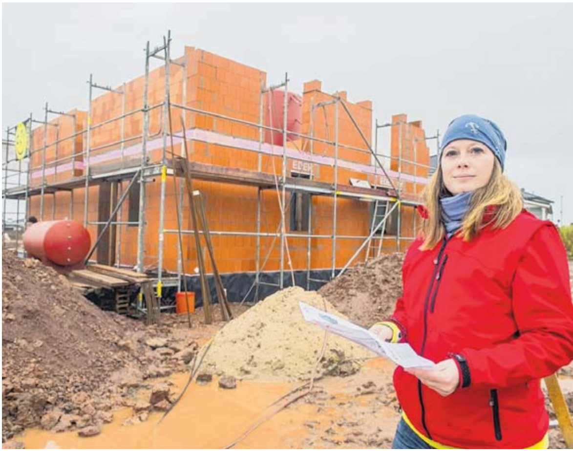
In der Nähe des Sportplatzes von Neukirchen entsteht zurzeit ein sogenanntes Aktivsonnenhaus. Diana Trotnow von der Chemnitzer Baufirma Fasa ist mit den Fortschritten auf der Baustelle zufrieden. FOTO: GEORG ULRICH DOSTMANN
