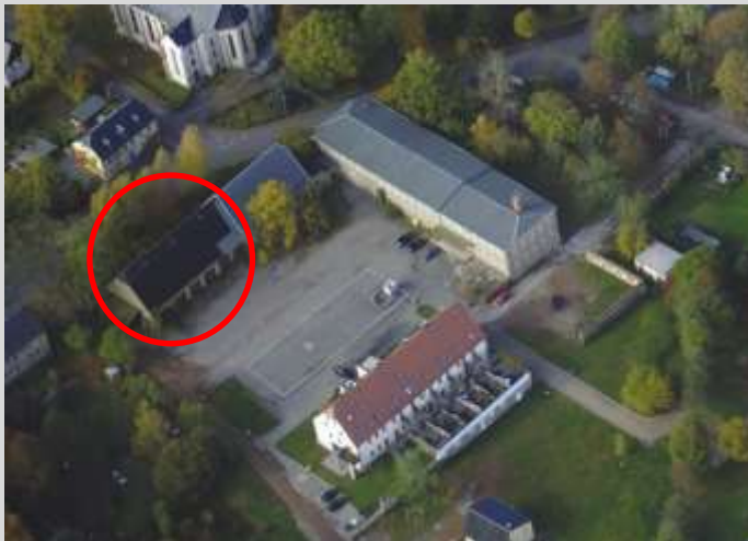
Historische Hofscheune: Luftaufnahme und geplanter Projektentwurf
