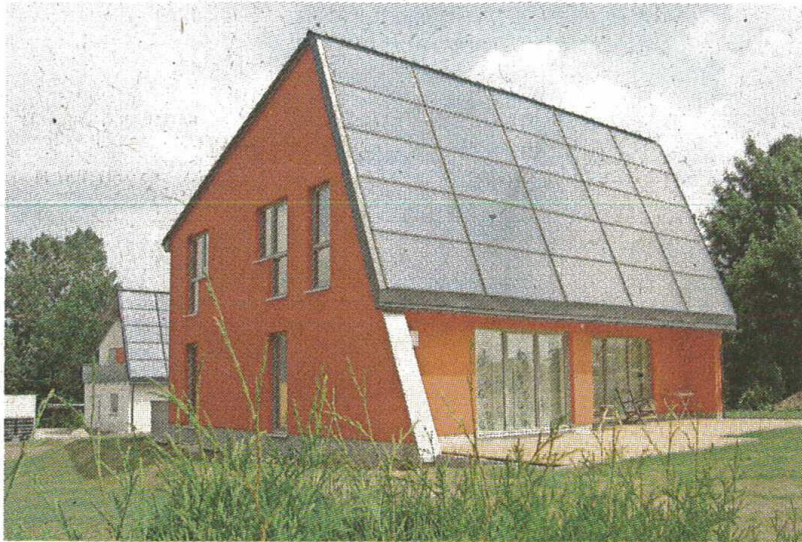
Das ENERGETIKhaus 100 holt sich seine Energie für Heizung und Warmwasser zu 90 Prozent von der Sonne.
