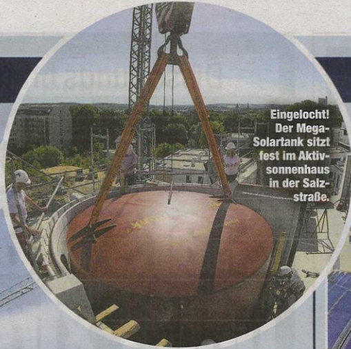
Präzisionsarbeit: Der 195 000 Kubikmeter Wasser fassende und 17,5 Meter hohe Solartank kurz vor der Installation.
