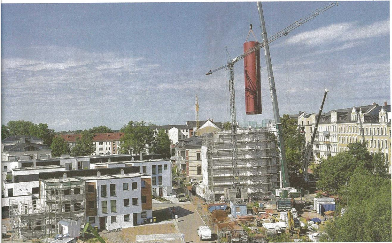
Haushoch und 18,6 Tonnen schwer baumelte gestern der Solarthermie-Tank des Fasa-Projekts auf dem Schlossberg am Mobilkranhaken. FOTO: ANDREAS SEIDEL
