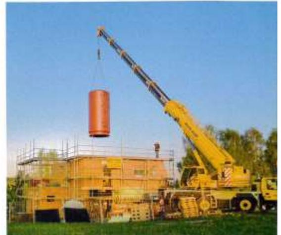
Der sechs Meter hohe Warmwasserspeicher wird senkrecht über zwei Ebenen ins Haus integriert.
