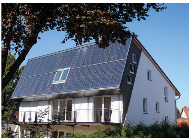
Abb. 1: Sonnenhaus Moosburg: Ein »klassisches« Sonnenhaus mit großer, steil geneigter Solarkollektorfläche. Bei dem Mehrfamilienhaus in Moosburg werden 70 % des Heizenergiebedarfs mit 64 Quadratmeter Solarkollektoren gedeckt. (Foto: Bernd Kerscher)
