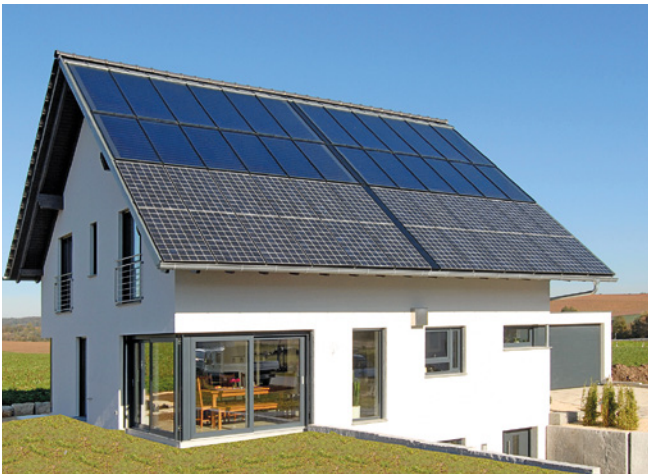
Abb. 3: KHB SHI Pfäuser zu BAFA: Ein Sonnenhaus der neuen Generation: Mit großen Solarthermie- und Photovoltaikanlagen wird Energie für Wärme, Strom und Mobilität erzeugt. (Foto: KHB-Creativ Wohnbau)
