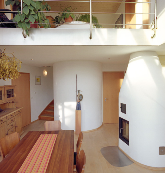
Abb. 10: Solarspeicher und Ofen gut in den Raum integriert. (Quelle: Sonnenhaus-Institut)
