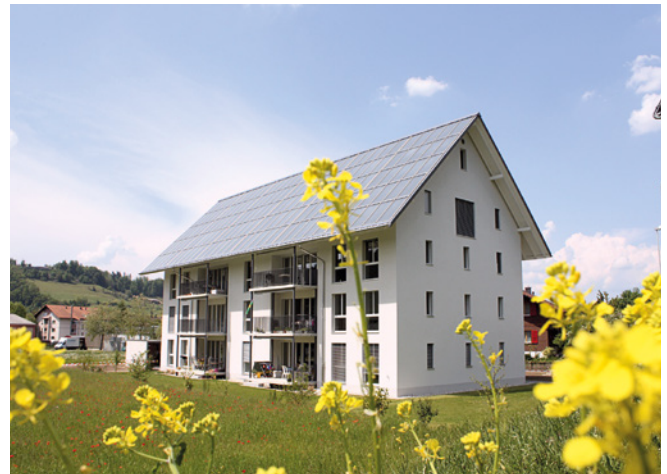
Abb. 4: MFH Jenni: Das erste zu 100 % solar beheizte Mehrfamilienhaus Europas. Der Schweizer Solarpionier Josef Jenni hat es im Schweizer Kanton Bern gebaut. (Foto: Jenni Energietechnik)
