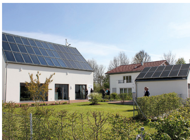
Abb. 2: Effizienzhaus Plus Burghausen: Das Effizienzhaus Plus in Burghausen wurde mit einem Sonnenhaus-Konzept gebaut. Es hat ein Solarthermie-Photovoltaik-Wärmepumpen-System. Dank der Solarwärmanlage erreichte die Wärmepumpe im zweiten Messjahr des Forschungsprojektes eine Arbeitszahl von 10,7. (Foto: Sonnenhaus-Institut)
