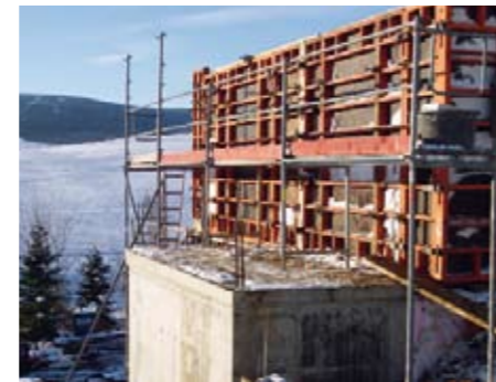
Die Außenwände der ersten beiden Etagen des dreistöckigen „Energetik-Cube“, die in Sichtbeton entstehen, werden zunächst verschalt.
