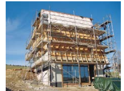
Am Fuße des Fichtelberges wird das Hauskonzept von Fasa an einem sonnigen Südhang umgesetzt. Erstmals setzt der Bauräger dabei eine Kombination aus Sichtbeton und massiver Holzbauweise ein. Auf dem Bild links ist der Platz für das fast 15 m 2 große Glaselement zu sehen. Rechts ist der passive Sonnenfänger bereits eingebaut. Das mittlere Foto zeigt das Gebäude von hinten und den beeindruckend weiten Blick zum Keilberg auf der tschechischen Seite des Erzgebirges.
