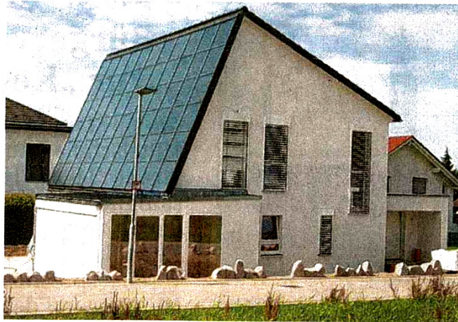
Dieses Sonnenhaus errichtete die Chemnitzer FASA AG in der Gemeinde Lauf bei Baden-Baden. Foto: FASA AG Chemnitz
