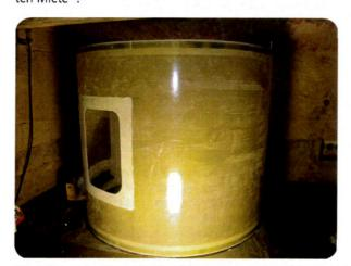
Ein "Kellerspeicher" im denkmalgeschützten alten "Schloss-Kontor" in Chemnitz. Die Einzelteile dieses Speichersystems wurden durch den sehr engen Treppenzugang transportiert und dann vor Ort zu einem homogenen Pufferspeicher zusammen gefügt.
