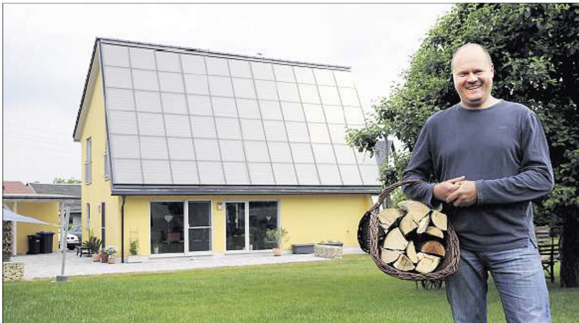
Jörg Rasehorn hat gut Lachen: Das Ganzjahressolarhaus, das er mit seiner Frau in der Gartenstraße in Neustadt errichtete, ist im vergangenen Jahr mit Heizkosten von rund 120 Euro ausgekommen. Im Zeitraum zwischen Ende Oktober und Mitte Januar, als die Sonne kaum schien, musste er an einigen Tagen zwei bis drei Körbe Holz im Kaminofen verfeuern, insgesamt zwei Schüttraummeter. Foto: Peter Cissek
