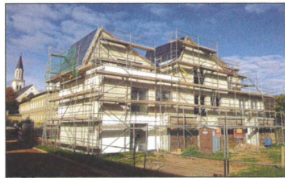
Die Ostansicht der Gutshofhäuser mit der Natursteinmauer
