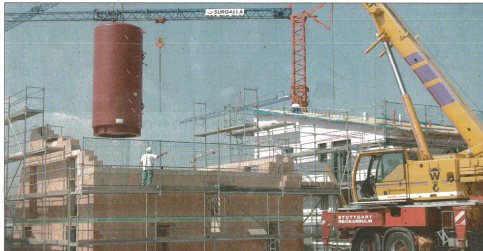
Diese Woche schwebte der riesige Solarspeicher ins Haus ein. In der Ehninger Donaustraße kann fast vollständig mit der Kraft der Sonne die nötige Energie bereit gestellt werden. Foto: Weigert
