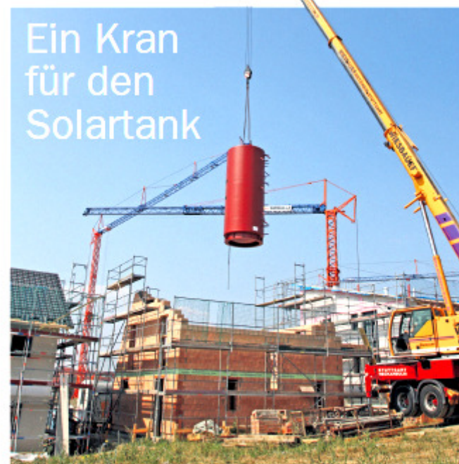
Ehningen: In Bühl II landet der 2,5-Tonnen-Speicher in einem Neubau
