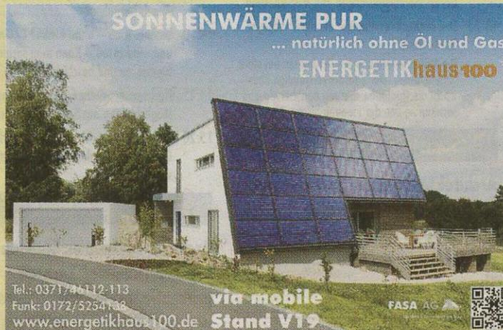
Das Prinzip ist einfach: Die Sonne erwärmt im Sommer den perfekt isolierten Solar-speicher, ohne je dafür eine Rechnung zu verlangen. Im Winter bedienen sich die Hausherren kostenlos aus diesem Tank. Und die Wärme im Speicher reicht dann bis weit ins neue Jahr. Die spezielle Neigung der Solar-kollektoren sorgt dafür, dass das System auch im Winter mit Sonnenwärme beladen werden kann. Bei längerer extremer Witterung, kann
