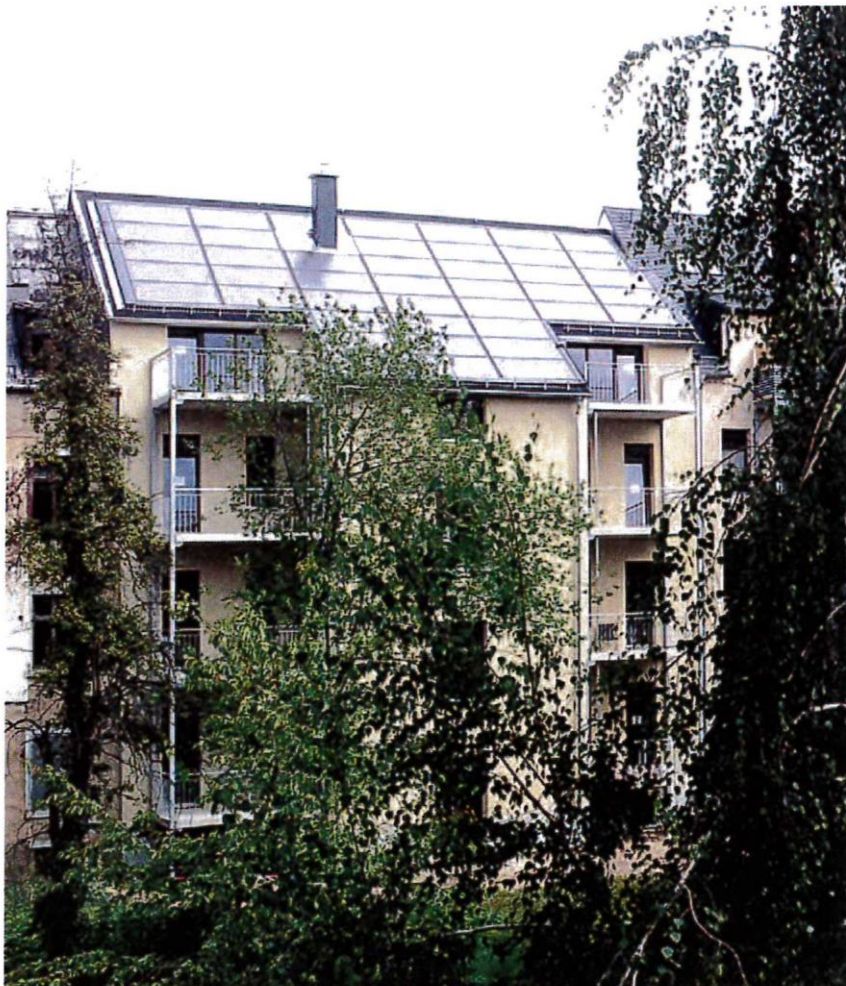
100 m 2 Solarkollektoren sind auf der Rückseite des Gründerzeithauses installiert.
