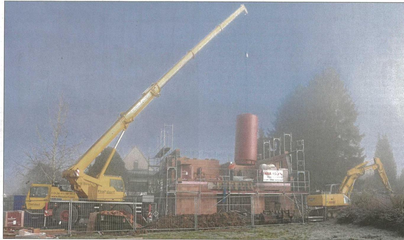
Millimeterarbeit am frühen Morgen: Der Kranführer fügt den Wärmespeicher-Kessel passgenau in den Rohbau des Einfamilienhauses an der Bohlscheider Denkmalstraße ein.
