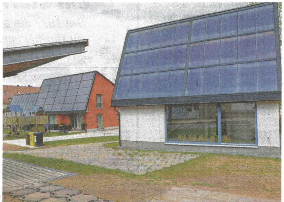
Verschiedene individuelle Energetikhäuser wurden von der Fasa AG im Chemnitzer Solar Areal „Rittergut Rabenstein“ gebaut, wo auch eines besichtigt werden kann. Foto: Ulli Schubert
