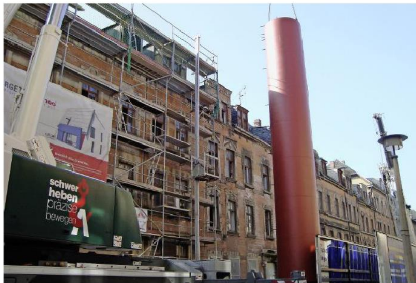
Mit einem Kran wird der Solartank in das denkmalgeschützte Gebäude an der Kanalstrasse in Chemnitz eingesetzt. Foto: zvg
