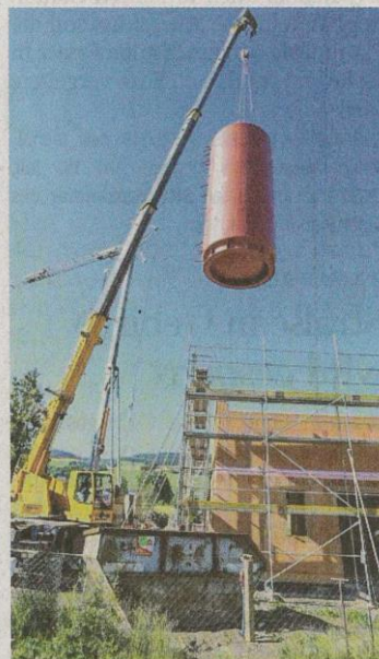
Der 2,7 Tonnen schwere und 5,80 Meter hohe Behälter schwebt per Kran in den Rohbau. FOTO: JAN GÖRNER
