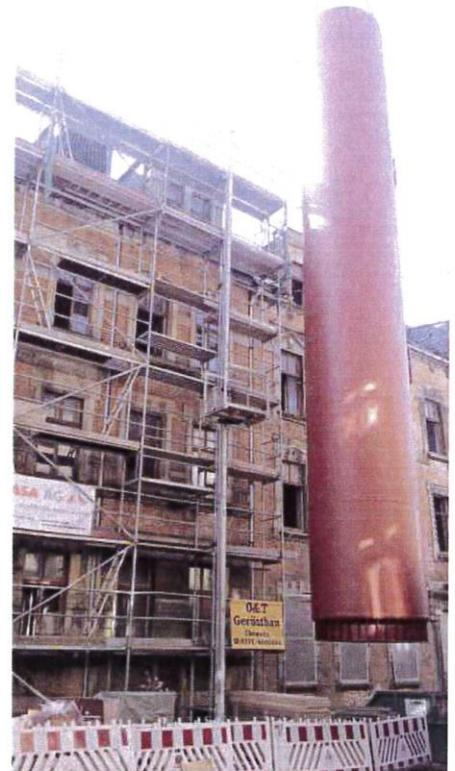
Der grosse Wärmespeicher wird mit einem Spezialkran von oben ins Gebäude eingebracht.
