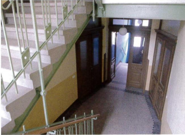
FOTOS: FASA AG
