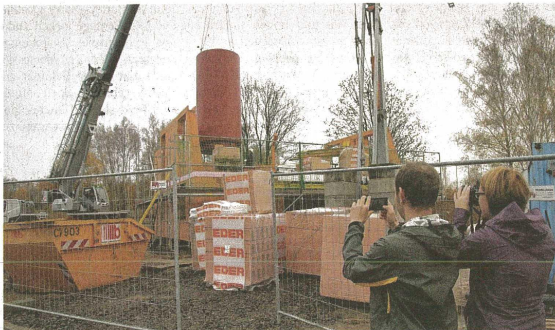
Marco und Susann Wya verfolgen den Einbau des großen Solarspeichers in ihr künftiges Eigenheim.
