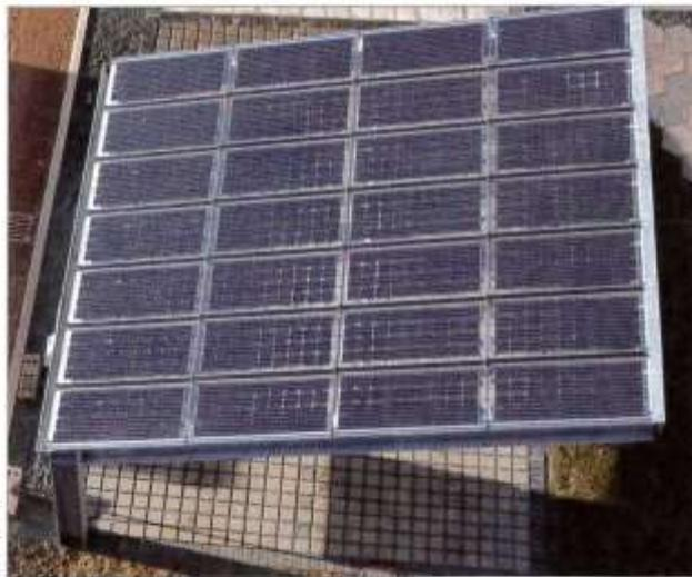
Die PV-Anlage auf diesem Carport erzeugt rechnerisch mehr Strom, als die Bewohner des Solarthermie-Hauses in Chemnitz übers Jahr verbrauchen.
