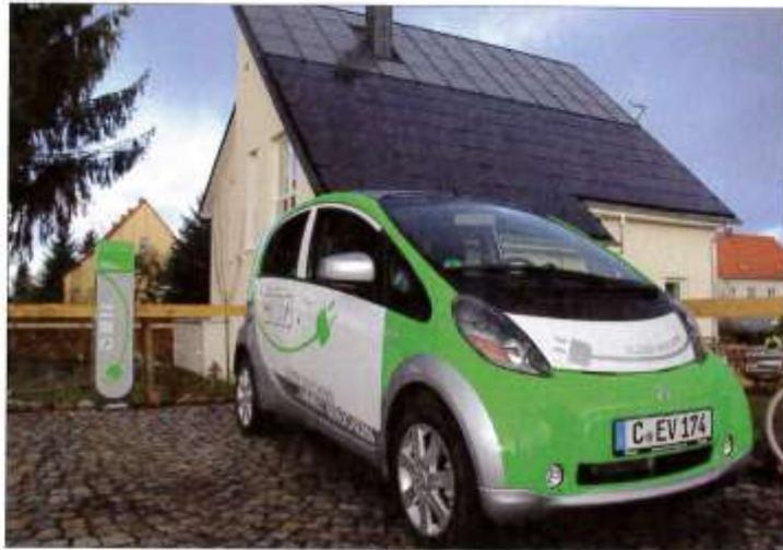
steilen Dachflächen 46 Quadratmeter große Kollektorflächen integriert. In Kombination mit einem 9-Kubikmeter-Langzeitwärmespeicher wird eine solare Deckungsrate von über 65 Prozent erreicht. Den restlichen Bedarf deckt ein Kaminofen mit Hilfe von etwa zwei bis drei Festmeter Stückholz pro Jahr. Wärmeseitig ist das energieautarke Haus somit nicht ganz unabhängig.
