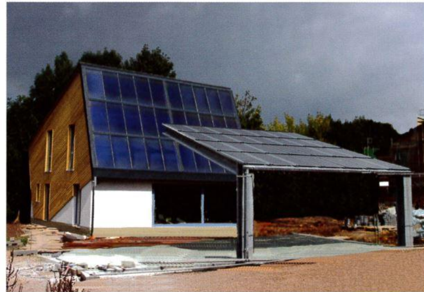
Die Photovoltaikanlage befindet sich auf dem Carport. Foto: FASA AG
