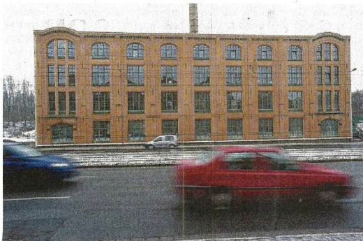
Im Frühjahr sollen die ersten Mieter im unteren Gebäude an der Zwickauer Straße einziehen, mit Nutzern der weiteren Häuser laufen Gespräche beispielsweise über Gastronomie und Kunstprojekte.
