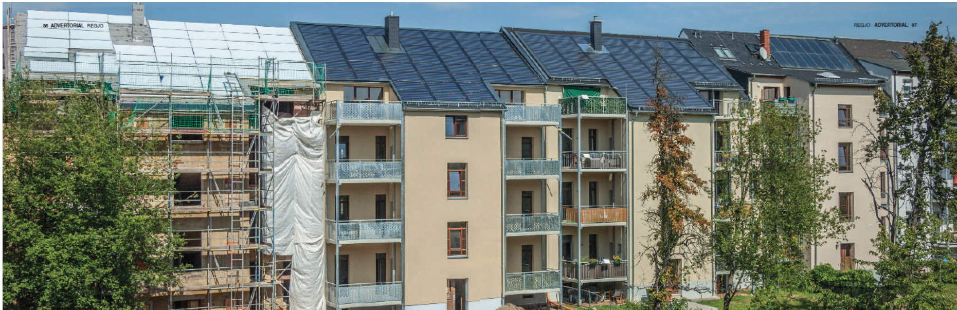
In der Kanalstraße in Chemnitz sind die Häuser energetisch gekoppelt, so dass sie sich gegenseitig mit überschüssigen Solarerträgen versorgen.
