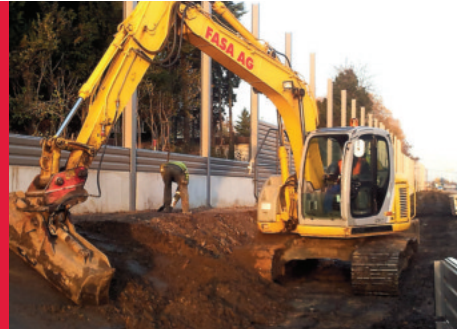
Austausch von reparaturbedürftigen Lärmschutzelementen
