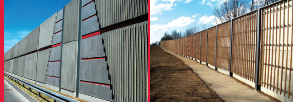
A10 in Brandenburg Hochabsorbierende Betonlärmschutzwand in Fertigteilbauweise
