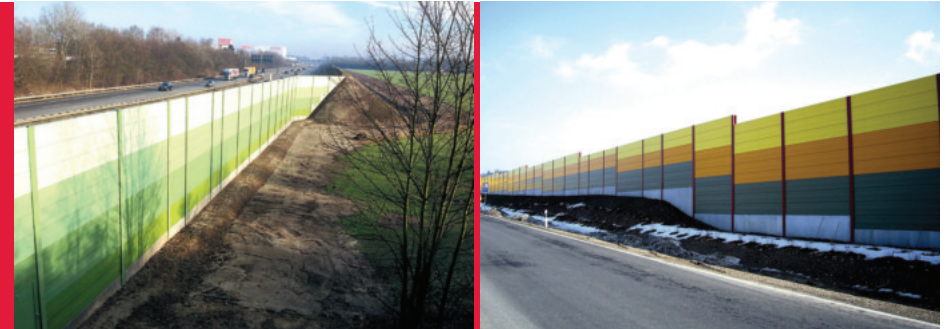
A1 in Schleswig-Holstein Hochabsorbierende Aluminiumwand auf Bohrfahlgründung
