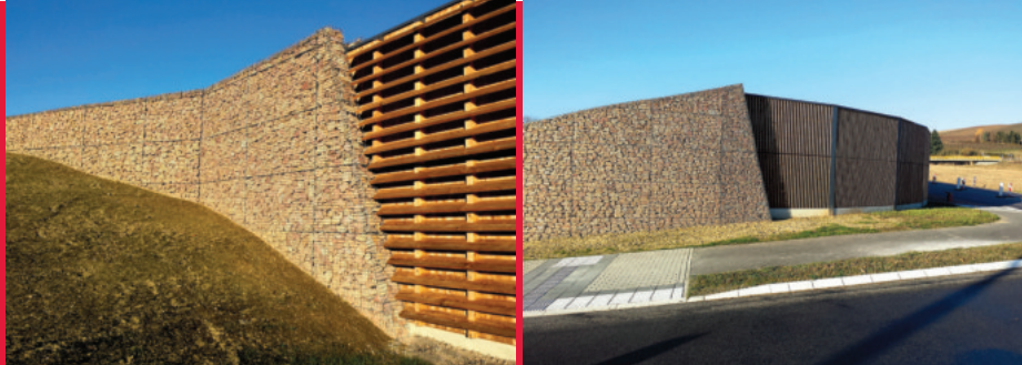
B41 in Rheinland-Pfalz Hochabsorbierende Lärmschutzwand aus Holz und Natursteingabionen
