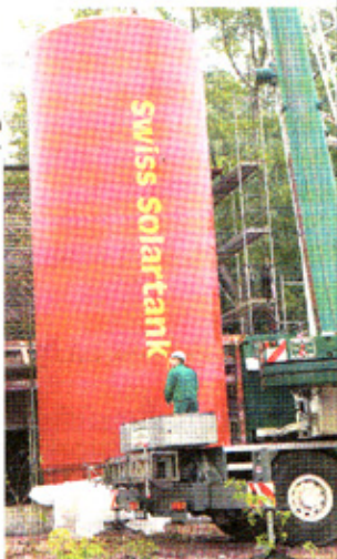
Dieser rote Zylinder fasst 100 000 Liter Wasser
