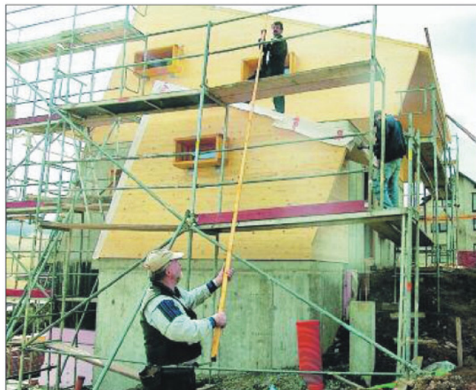
Uli Barthel, Uwe Pfüller und Florian Schauer (v. l.) bauen an der Emil-Riedel-Straße in Oberwiesenthal das Energetik-Haus 100. –FOTO: BRIGITTE STREEK
