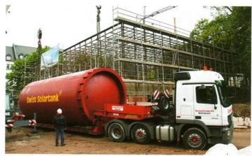
der DDR an der Zwickauer Straße/Ecke Marianne- Brandt-Straße wird so zu einem modernen, solarthermisch beheizten Bürogebäude entwickelt – einmalig in Chemnitz und Deutschland! Das Dach wird mit einer 250 Quadratmeter großen Solarthermieanlage bestückt, die mit einem Langzeitsolarspeicher im In-
