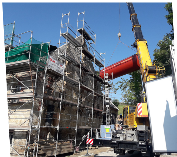
Anlieferung und Einbau des Warmwassertanks in das „Aktivsonnenhaus Sport“.
