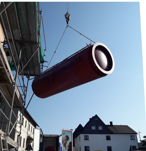
Anlieferung und Einbau des Warmwassertanks in das „Aktivsonnenhaus Sport“.
