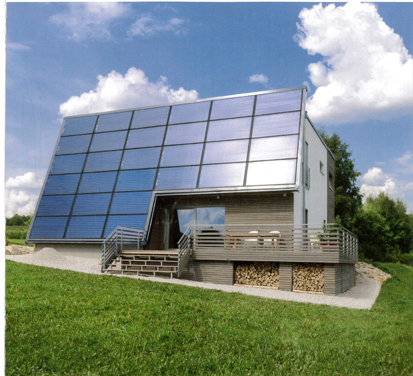
Mit der großen, sehr steilen Solarthermiefläche erreicht die FASA AG solare Deckungsgrade über 90 Prozent in der Wärmeversorgung. Fotos (2): FASA AG
