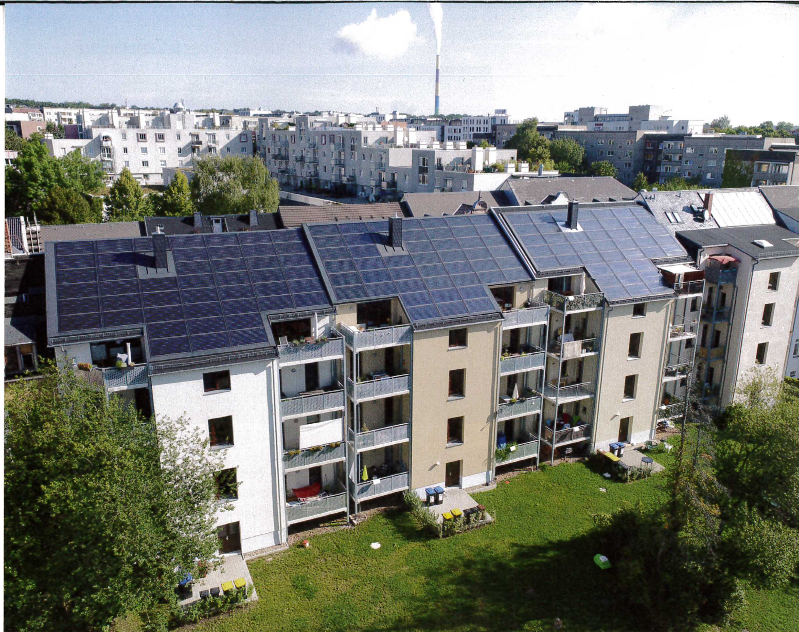
Die Solarkollektoren sind nur von der Rückseite aus zu sehen. Fotos (3): FASA AG
