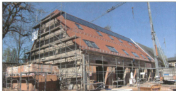
Baufortschritt an den Scheibenhäusern
