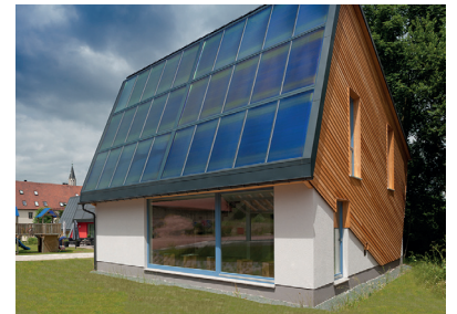
ENERGETIKhaus100® autark Quelle: Ulf Dahl
