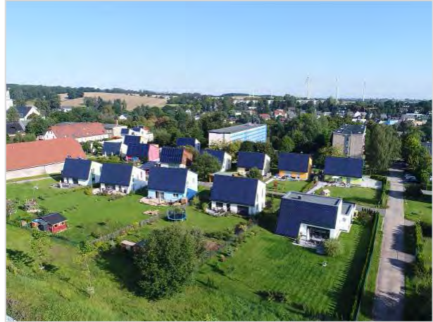
Wohnsiedlung mit eingebauten Swiss Solartanks
