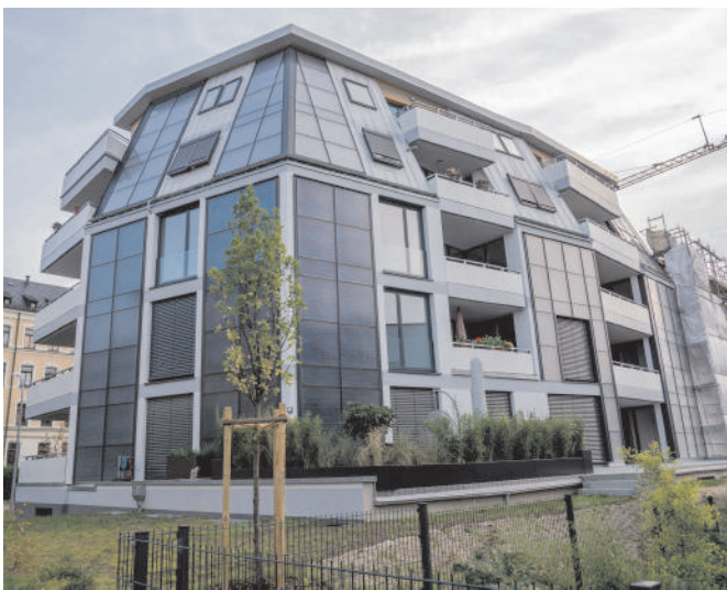
Das Solardomizil der FASA AG bezieht die Hälfte der benötigten Heizenergie von der Sonne. Foto: FASA AG
