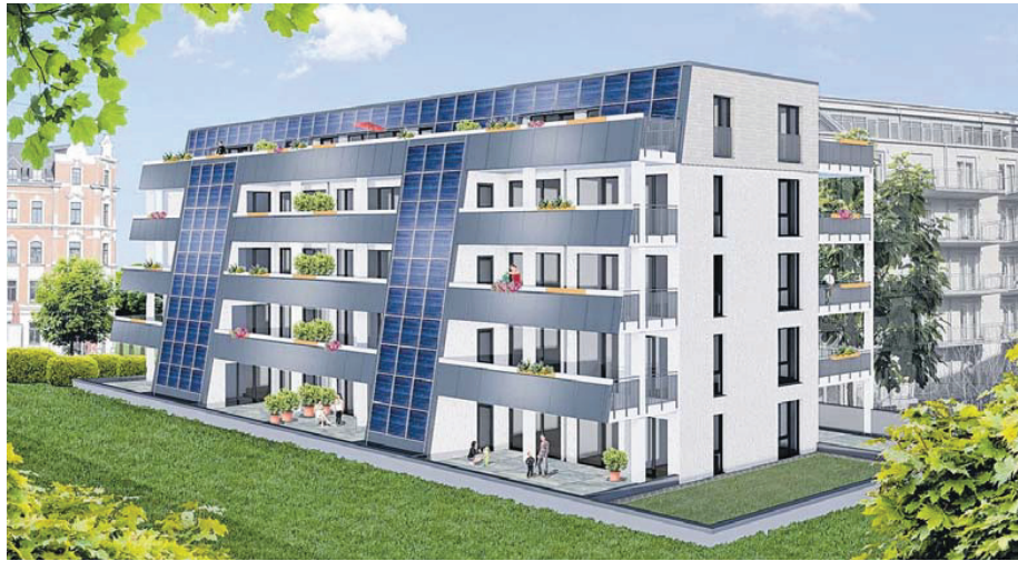
Das sogenannte Solar-Domizil III an der Salzstraße wird in klassischer Ziegelbauweise errichtet und soll an seiner Südfassade mit insgesamt 330 Quadratmeter großen Sonnenkollektoren zur Warmwasserbereitung ausgestattet werden.
