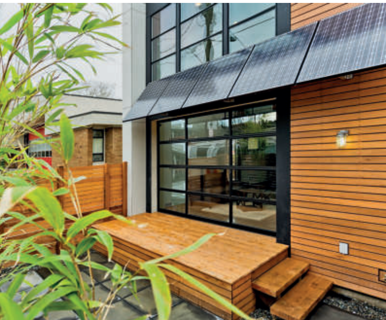
Auch an der Fassade lassen sich Solarmodule geschickt platzieren.
