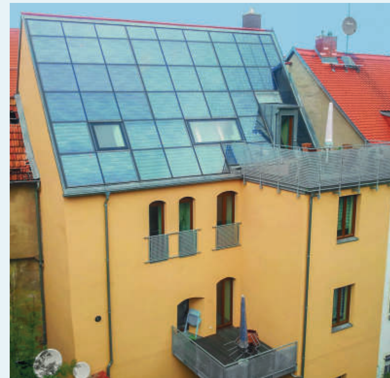
Solardach mit integrierten Dachfenstern für ein Haus aus dem 16. Jahrhundert.
