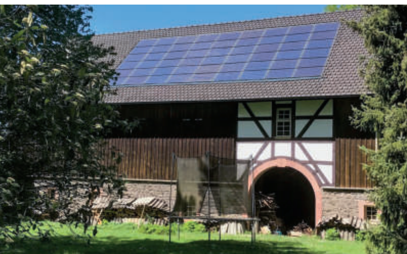
In die Dachfläche integrierte PV-Anlage eines Baudenkmals.
