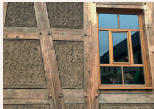
Neueste Energietechnik trifft auf traditionelles Fachwerk und Lehmwände.
