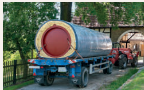
Den gedämmten Wärmespeichertank durch das Hoftor zu bringen, war Millimeterarbeit.
