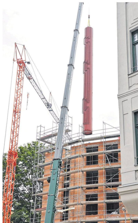
Der 32.000 Liter fassende Warmwasserspeicher ist 19 Meter hoch und wurde per Schwerlastkran in dem sechsgeschossigen Rohbau versenkt.
