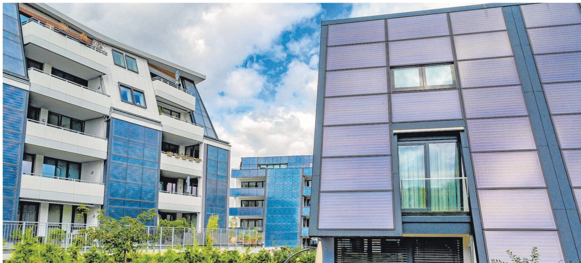
Solkollektoren auf Häusern der Fasa AG: Im Hintergrund das fast fertiggestellte Bauprojekt Solardomizil III.
