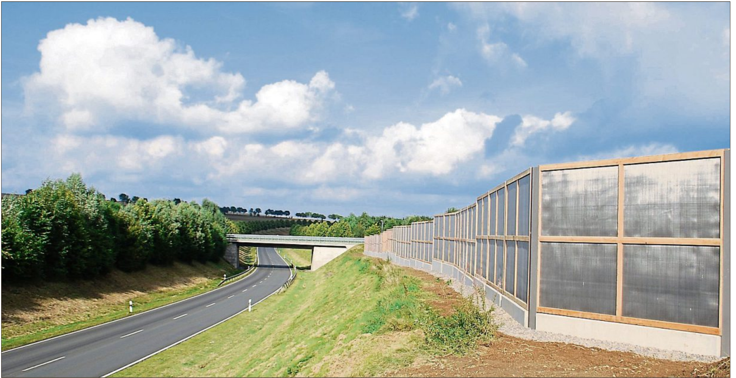
Holzlärmschutzwand mit Edelstahlgitter kurz vor der Baufertigstellung.
