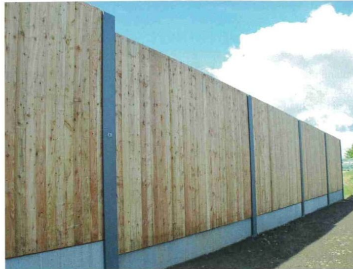
Im Bau befindliche Holzlärmschutzwand in Marienberg im Erzgebirge
