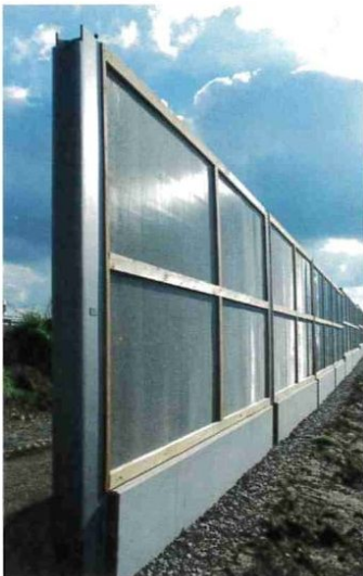
Im Bau befindliche Holzlärmschutzwand in Marienberg im Erzgebirge
