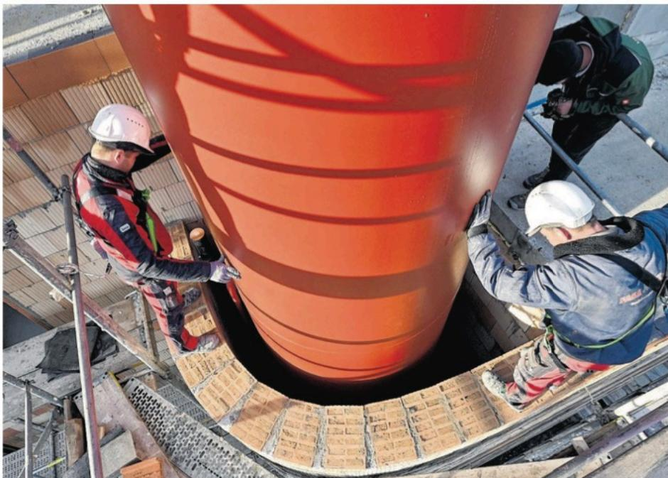
Millimeterarbeit: An der Dorotheenstraße im Schloßviertel ist am Montagvormittag ein 16 Meter langer Solarspeicher in ein neues Mehrfamilienhaus der Fasa AG eingesetzt worden. In Zeiltupe senkte ein Schwerlastkran den tonnenschweren Tank in den Schacht.
