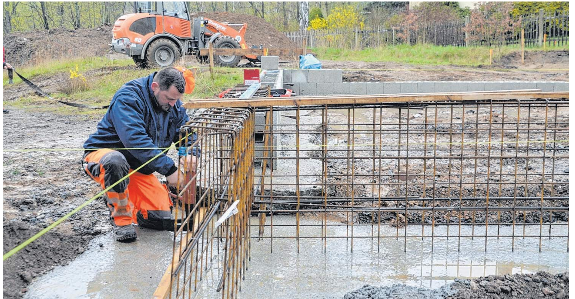
Baubeginn in Braunsdorf: Arbeiter der Fasa AG aus Chemnitz setzen das Fundament des künftigen Aktivsonnenhauses.
