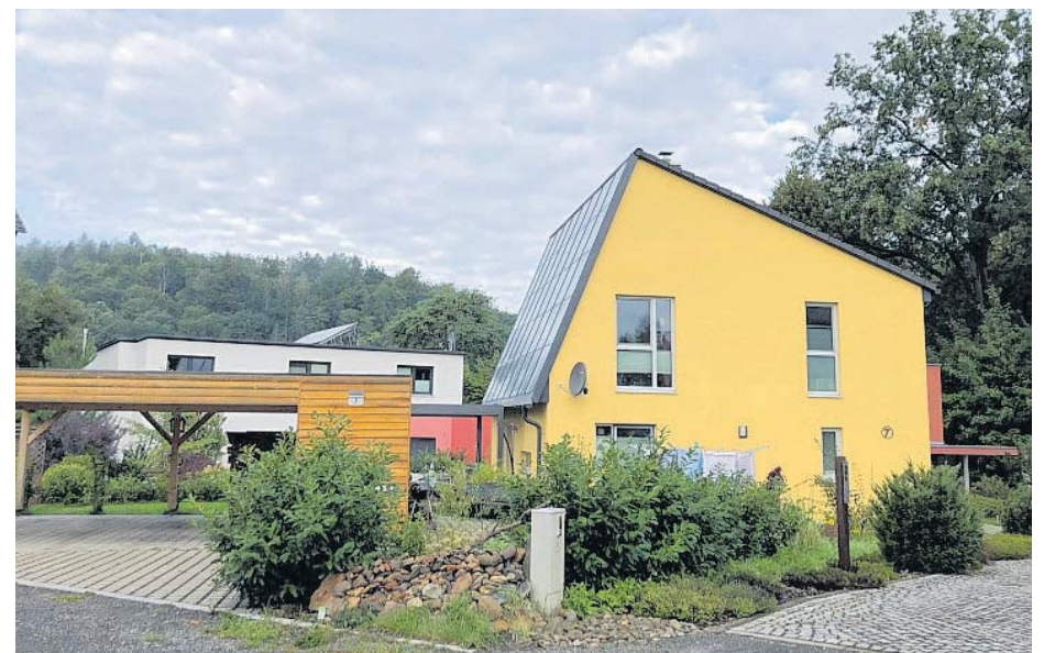
Nahe dem Bahnhof von Braunsdorf steht bereits ein Solar-Einfamilienhaus der Fasa mit dem typischen Schrägdach.
