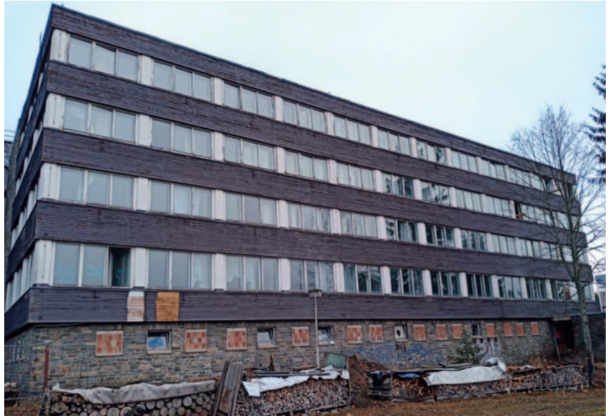
So sah das Bettenhaus des Sporthotels Oberwiesenthal vor der Sanierung aus. Errichtet wurde es in den 1970er Jahren und stand nach der Wende lange leer.
