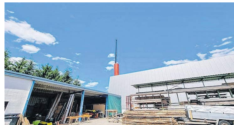
Vor wenigen Tagen wurde der neue, etwa sieben Meter hohe Energiespeicher in die künftige Produktionshalle gehoben. FOTO: FIRMA WERKFORM
